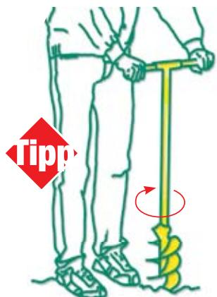
Ausheben der Fundamentlöcher mit ca. 30 x 30 cm. Die genau Tiefe (frostsicher bei ca. 80 cm) ist abhängig von der Pfosten-Höhe und der Lage der unteren
