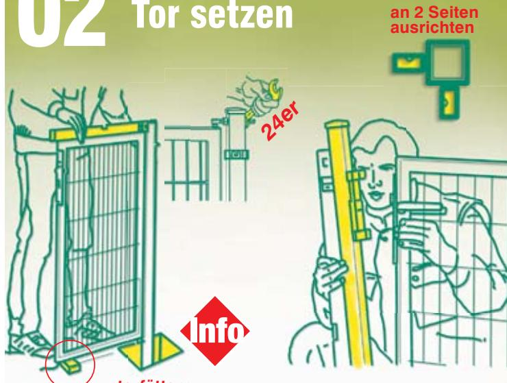
Für Tor-Pfosten Fundament-Löcher lt. Pkt. 03 erstellen. Tor-Flügel mit Holz-Keil unterfüttern und waagrecht ausrichten. Pfosten an zwei Seiten
