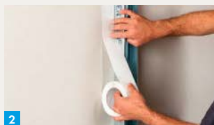
2. Trenn-Fix neben Profil kleben
