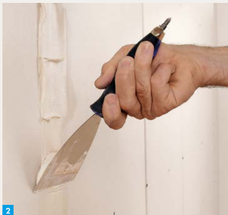
2. Mit dem Schraubgriffspachtel scharf abziehen.
