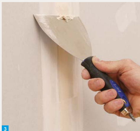
3. Ausgehärtetes Material nach ca. einer Stunde abstoßen.
