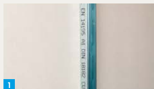
1. Profil auf angrenzendes Bauteil montieren
