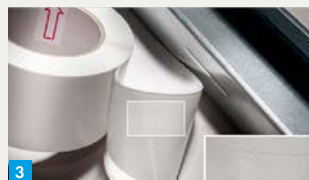
3. Schmale stark haftende Klebezone direkt an das Profil anschließen
