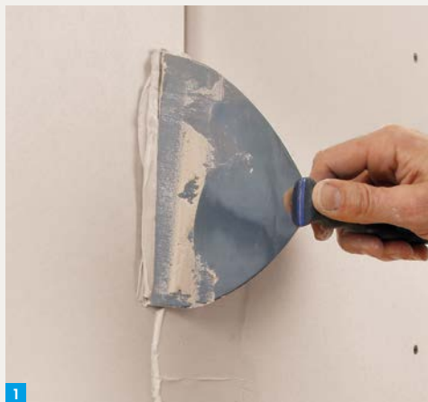
1. Knauf Uniflott in die Gipsplattenfuge einbringen.
