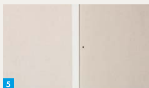
5. Gipsplatten mit ca. 5 mm Abstand montieren
