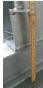
Einbautiefe des Stahlträgers (ca. 22,5 cm)
