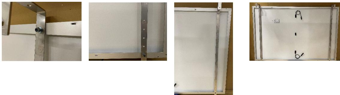
**Schritt 2:** Montage des Wechselrichter mittels einer M8x20mm Schraube, selbstsichernder Mutter und zwei Unterlegscheiben. Anschluss der MC4 Kabel an das Panel und den Wechselrichter. Der Wechselrichter muss nicht an diesem Ort verschraubt werden er kann an jedem beliebigen Ort montiert werden. Es ist darauf zu achten, dass der Wechselrichter nicht an Bauteilen/Objekten anstößt und es ist gegebenfalls ein anderer Montageort zu wählen.
