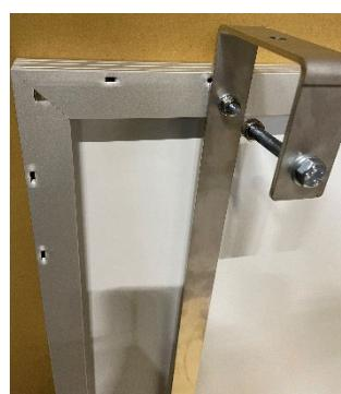
**Schritt 4:** Montage der unteren Befestigungen mittels M8x20mm Schraube, selbstsichernder Mutter und Unterlegscheiben.
