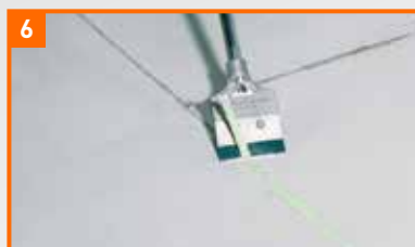
Ausgetretenen Estrich-Kleber nach dem Aushärten abstoßen
