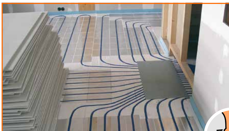
4 In die Wärmeleitbleche die Kunststoffheizrohre einlegen. Anschließend folgt das Verlegen der Estrich-Elemente wie auf Seite 21 beschrieben.
