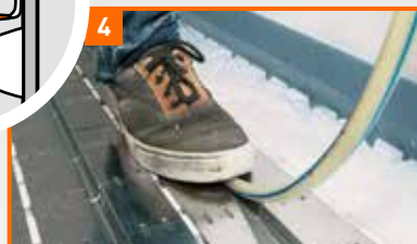
4 In die Wärmeleitbleche die Kunststoffheizrohre einlegen. Anschließend folgt das Verlegen der Estrich-Elemente wie auf Seite 21 beschrieben.
