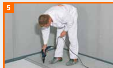
Powerpanel TE Elemente im Stufenfalz mit FERMACELL Powerpanel TE Schrauben verbinden
