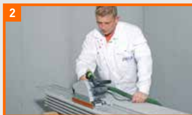
Für die erste Reihe den Falz abschneiden
