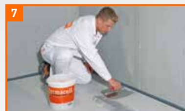
Bei Bedarf Stoßfugen und Verbindungsmittel mit FERMACELL Powerpanel Feinspachtel abspachteln
