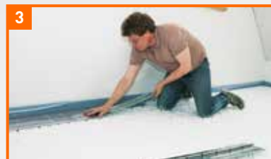
3 Wärmeleitbleche in die Polystyrolplatten einlegen.
