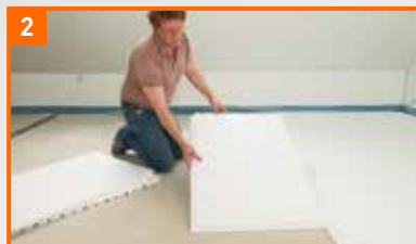
2 Systemplatten verlegen.
