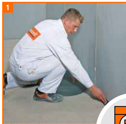
Randdämmstreifen verlegen
