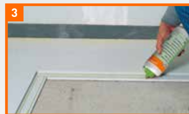
Im Falzbereich der Elemente den FERMACELL Estrich-Kleber auftragen
