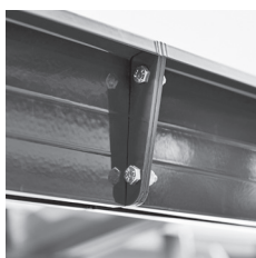
Pfettenverschraubung Edelstahl Schrauben/Muttern
